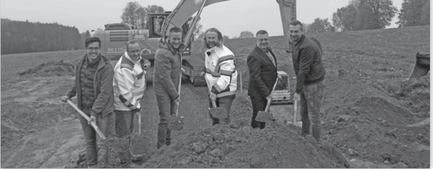
Spatenstich ländlicher Wegebau (von links): Maximilian Achatz (Bauleiter), Marco Dietl (Örtliche Bauleitung), Stefan Weiß (Bauoberleitung), Christian Rummel (Projektleitung), Bürgermeister Wildfeuer und Florian Schink (Geschäftsstellenleiter)
